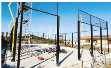
I lavori per il campo da padel sul terreno confiscato alla 'Ndrangheta
